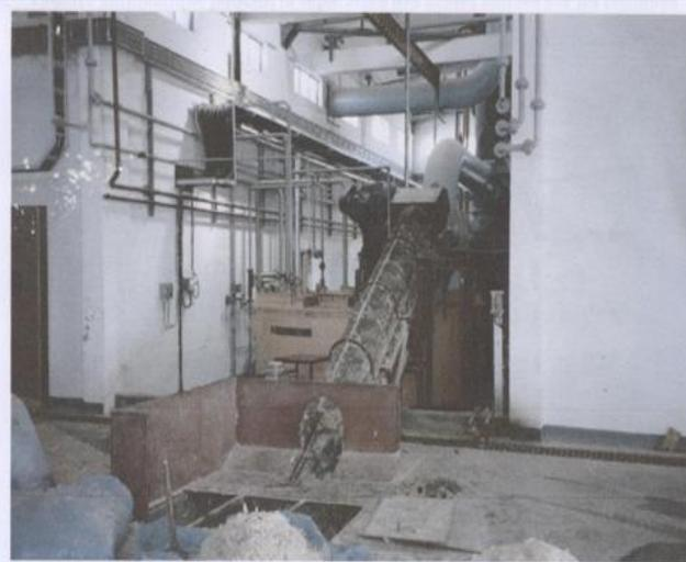
Hydrolyseur pour 30 tonnes de plumes sèche par opération
